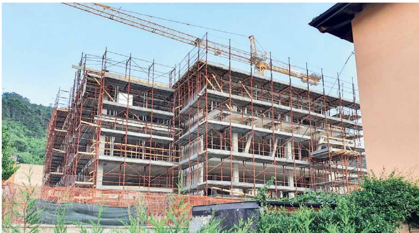
• Il nuovo condominio Residenza Jacopino in corso di realizzazione a Lizzanella oggetto delle contestazioni dei vicini
